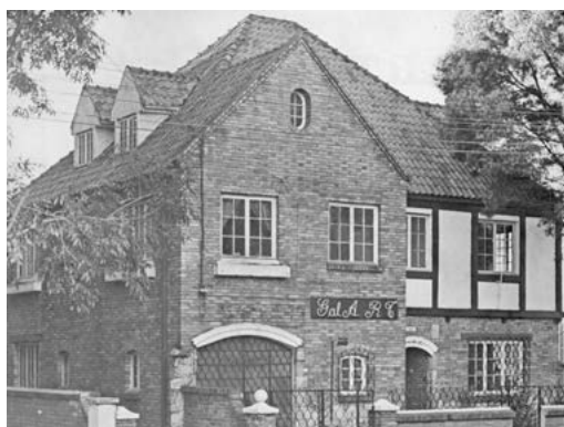
Fotografía de la casa en la que funcionaba la galería en el barrio La Merced de Bogotá.
