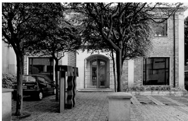
Fachada de la galería Casas Riegner, 2014.
