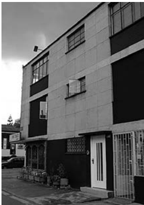
Fachada de la galería La Central, 2011.
