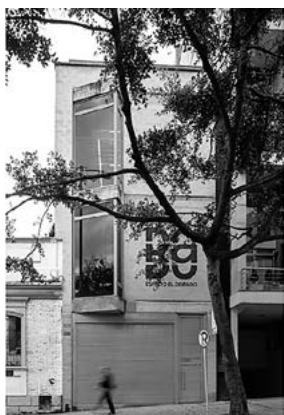
Fachada de la galería Espacio El Dorado, 2018.
